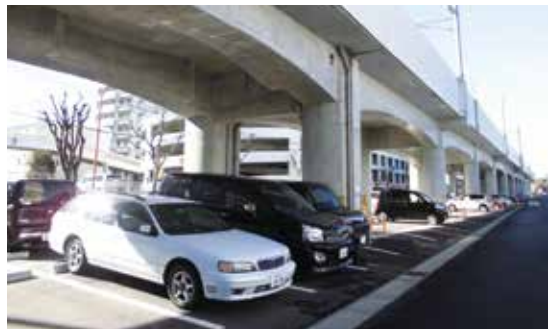
高架下駐車場
